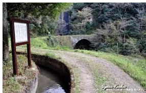
雄亀滝橋(美里町)
