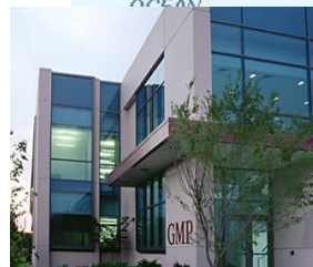
米国・セントジュード小児研究病院 BSL3適合GMP施設
